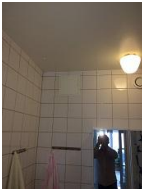
Inspektionslucka med påkopplingar av nya rör
