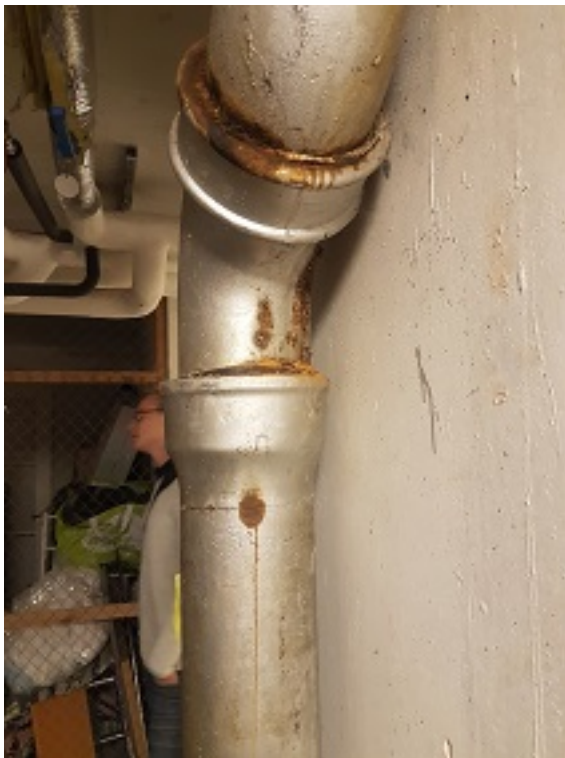
Gammal avloppsstam i källare
