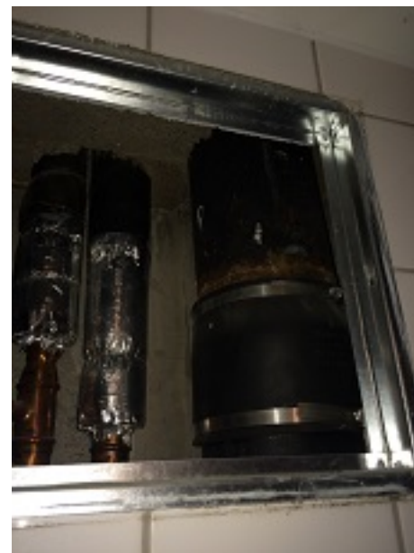
Inspektionsslucka med påkoppling av nya rör
